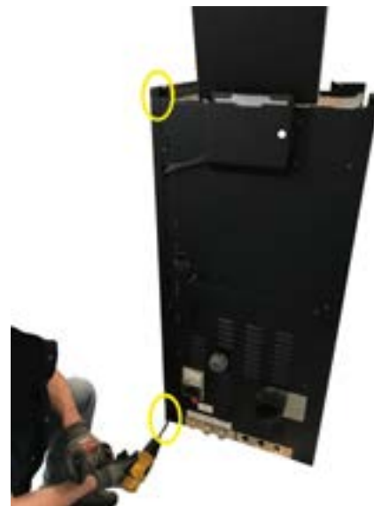
Fig. 37 - Bevestiging achteraan zijpaneel
