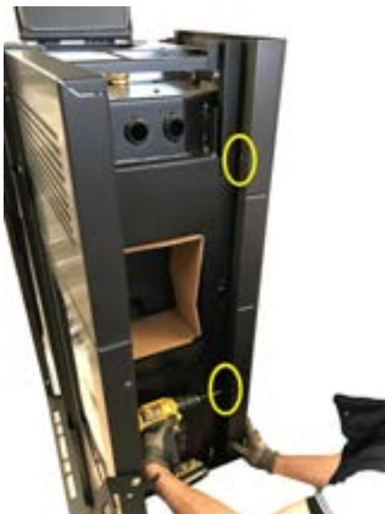
Fig. 36 - Bevestiging vooraan zijpaneel
